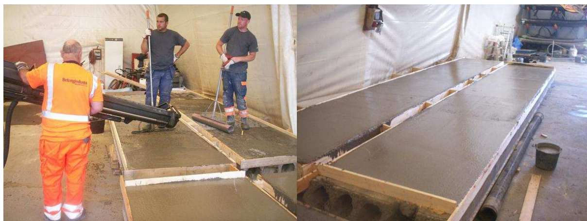
Figur 5 – Utläggning av pågjutning på aktuella HD/F-element visas till vänster. Till höger visas färdigt gjutresultat för element A och B.
