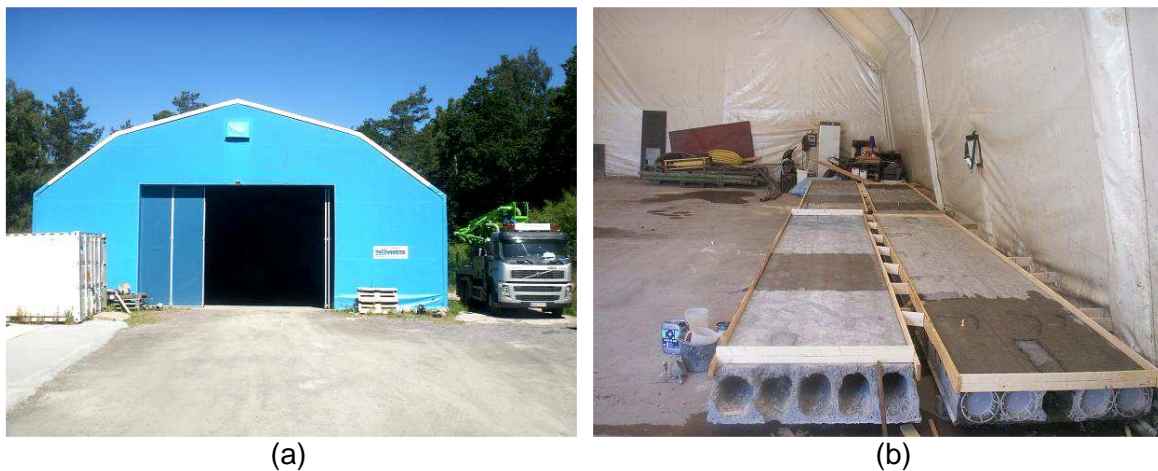
Figur 1 – (a) Försöken utfördes i ett stort tält där betongpumpar vanligtvis står uppställda. (b) Fyra håldäckselement upplagda på golvet i tältet.
