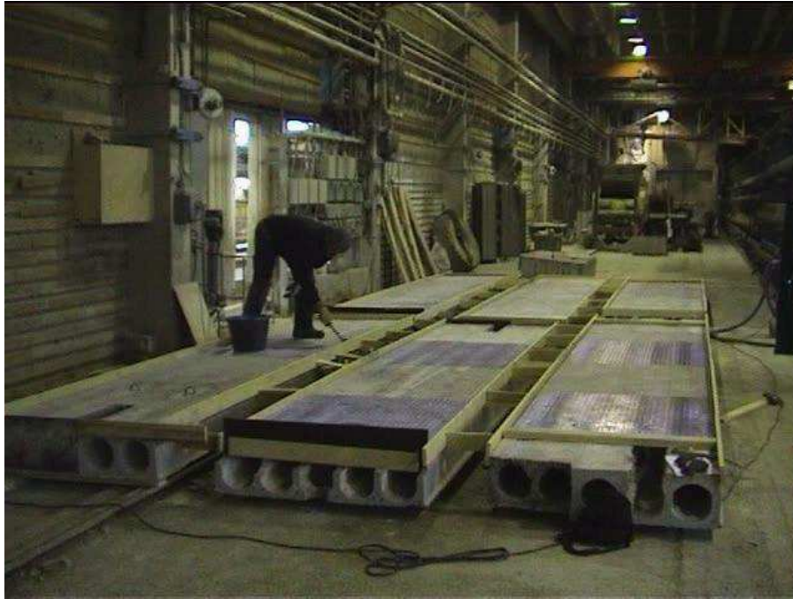
Figur 27 – Priming av HD/F dagen före pågjutning av fält A och C på platta 1, 2 och 3.
