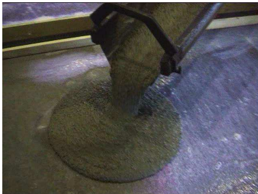
Figur 29 – Utläggning av pågjutning på HD/F-element.
