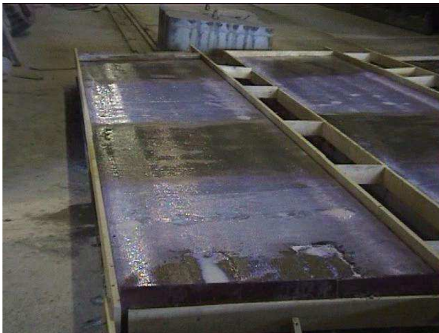
Figur 28 – Foto av platta 4 precis före pågjutning. Det framgår att primer och vatten har applicerats flödigt.
