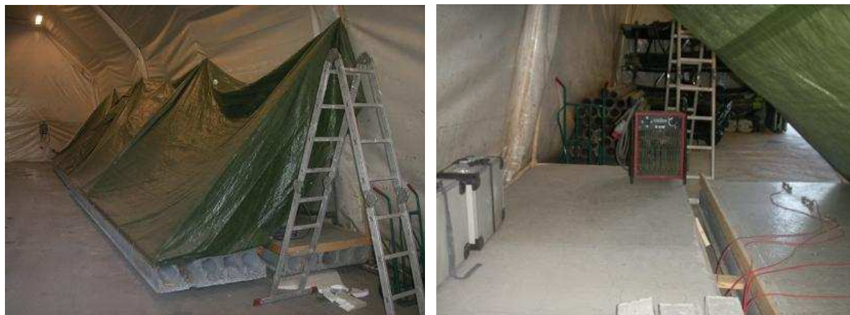
Figur 12 – Ca en månad efter pågjutning (slutet av juli) byggdes elementen in med presenningar. En värmefläkt (8 kW) placerades i respektive öppning för att torka ut luften över pågjutningarna.
